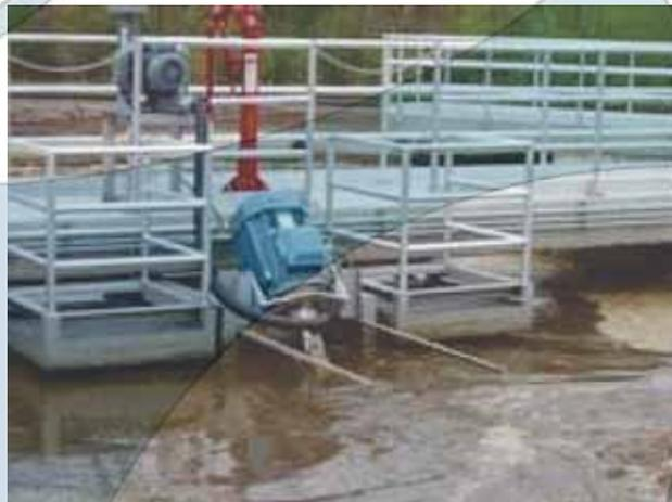
*рис.6 - простота и безопасность в содержании и осмотре аэраторов благодаря сервисным платформам, используемых при установке на мосты.*
